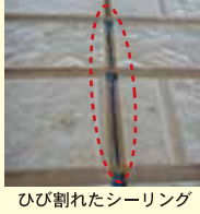
バルコニーの手摺りのシーリングが切れて、外壁に漏水した例。
