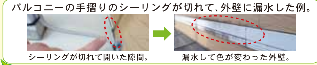
シーリングが切れて開いた隙間。
