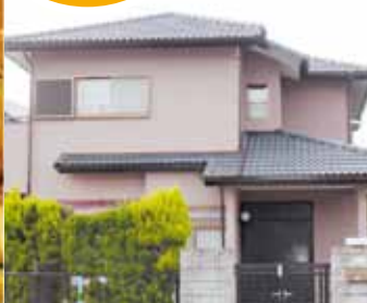
三田市つつじが丘 N様邸 エコ壁塗装工事費150万円(足場代・税込) リフォームローンのご利用例(150万円の場合) 月々均等払い ¥16,500×12回
